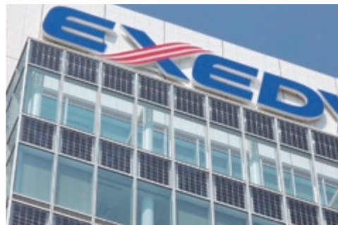
南側外壁に取り付けられた太陽光パネル
